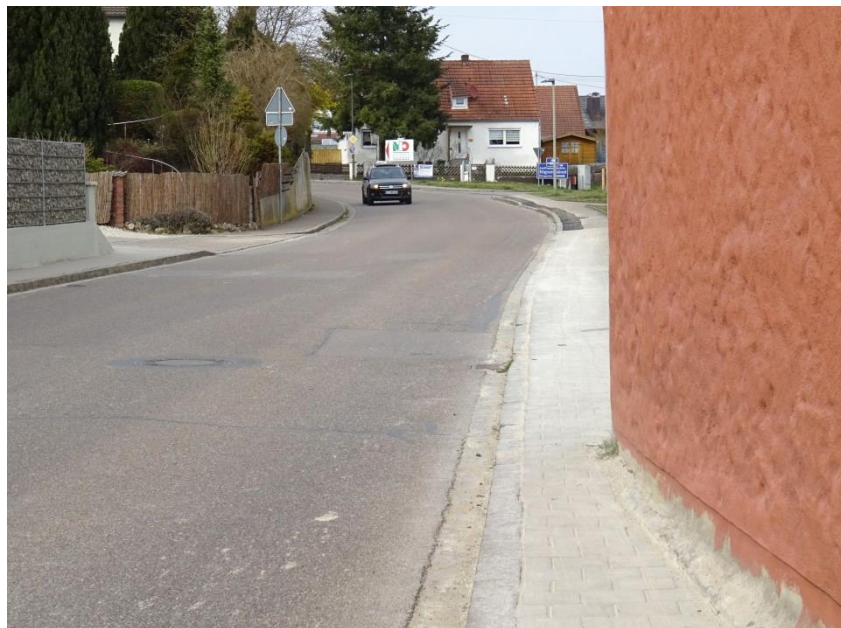
Abbildung 31: Engstelle Gehweg Schelldorfer Straße
