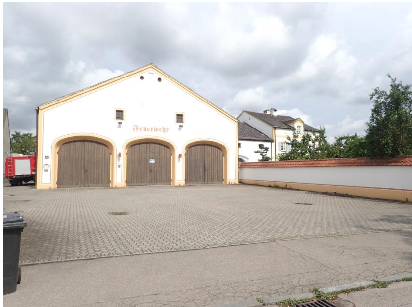
Abbildung 26: Feuerwehrhaus und -hof
