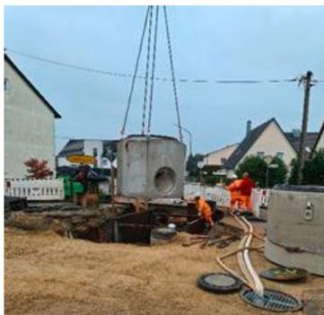
Der neue Schachtstandort erforderte die Anpassung der diversen Anschlüsse an diesen. Deren Krümmungen mussten neu berechnet und bestellt werden, was mit Lieferfristen verbunden war.
