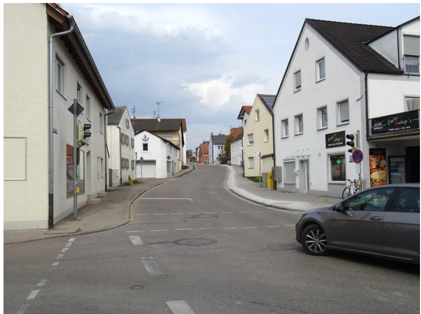
Abbildung 29: Kreuzung Ingolstädter / Schelldorfer Straße und Rackertshofener Straße
